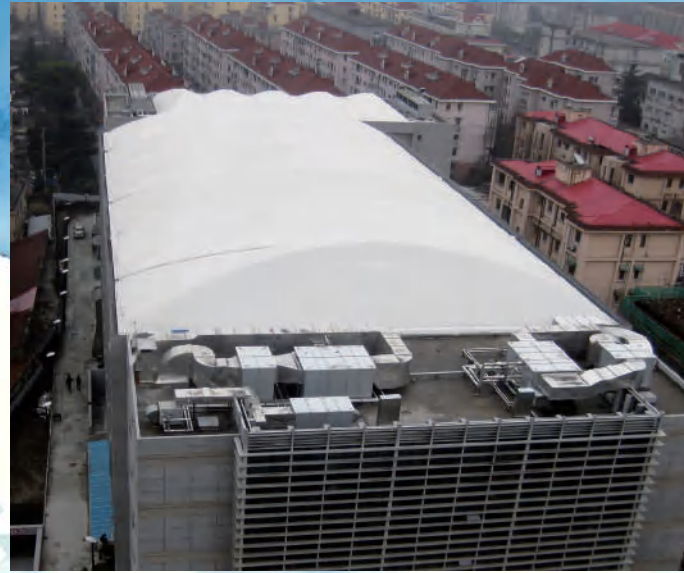
上海徐汇游泳馆 · Xuhui Natatorium
